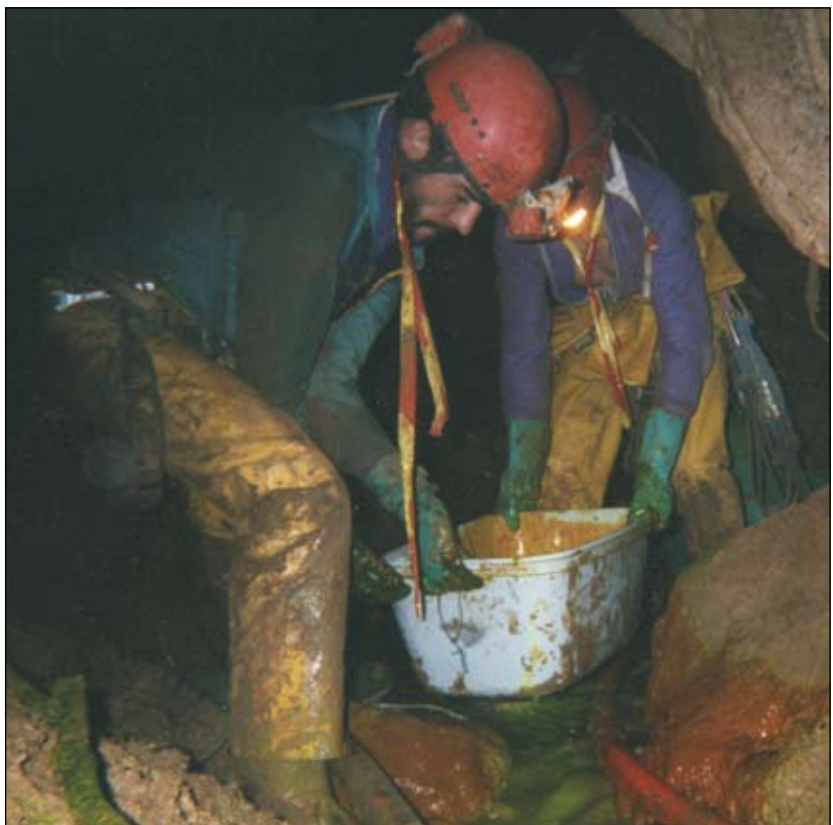
Injection à l'aven de la Boue
