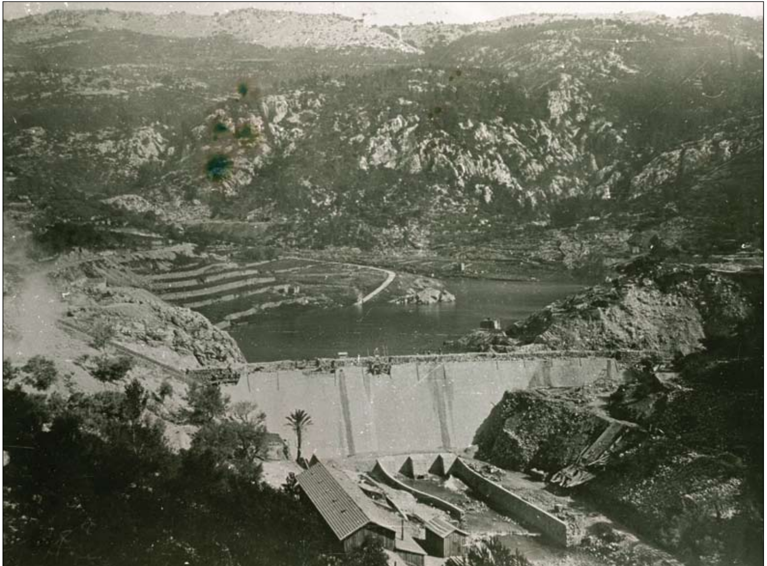
La retenue de Dardennes en 1911 au moment de sa construction. Au second plan les premiers contreforts de Siou Blanc
