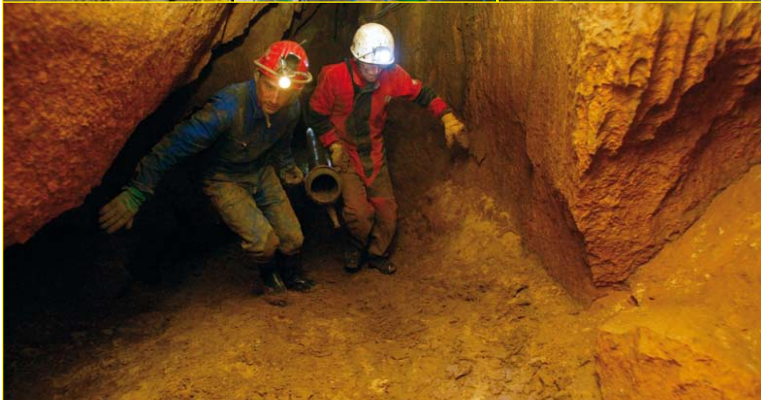
Le démontage des installations de pompage
