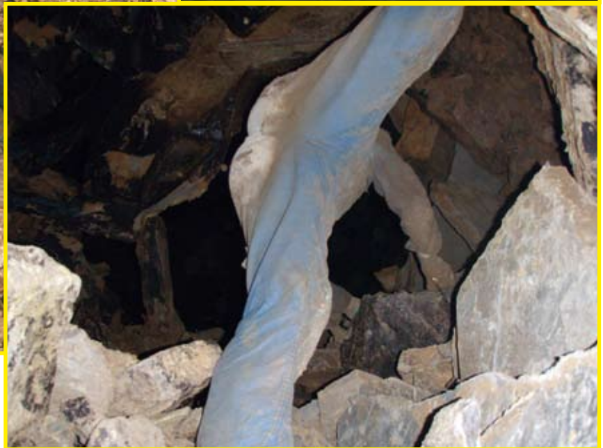
L'intimidante remontée dans le château de cartes vertical de la trémie
