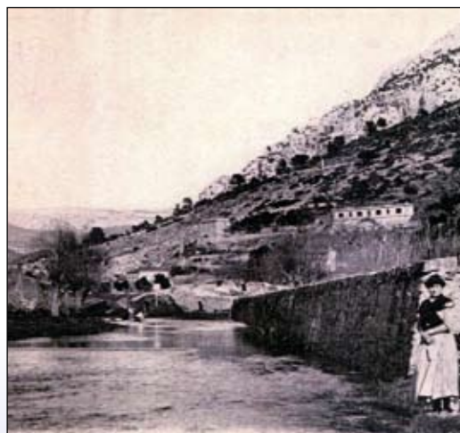
La digue dite de «Vauban» au Jonquet.
