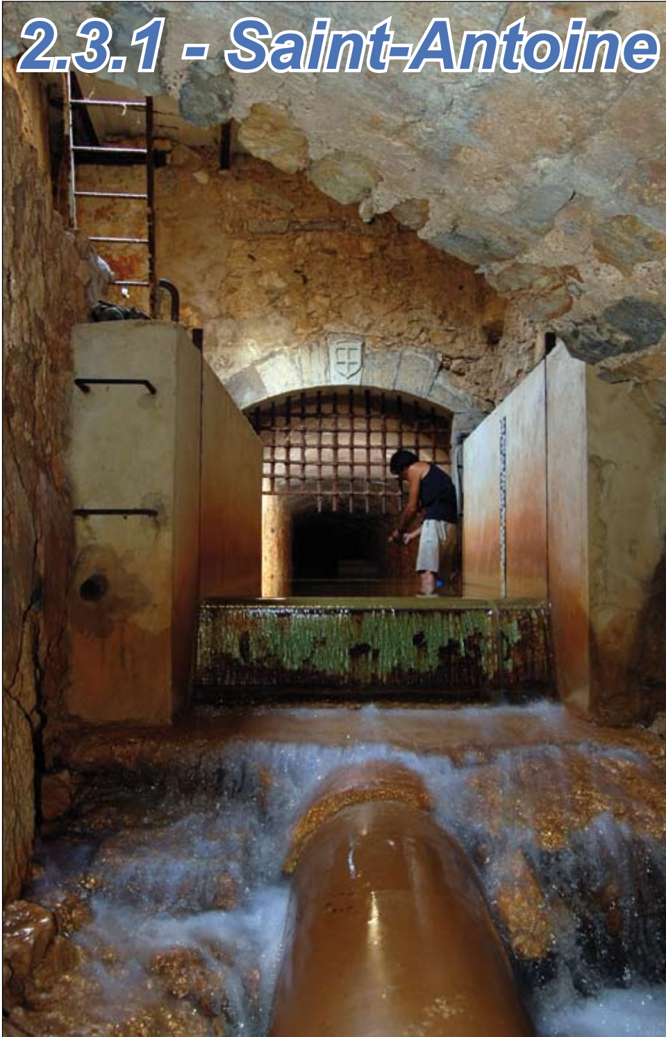
La galerie d'accès au siphon 1.
