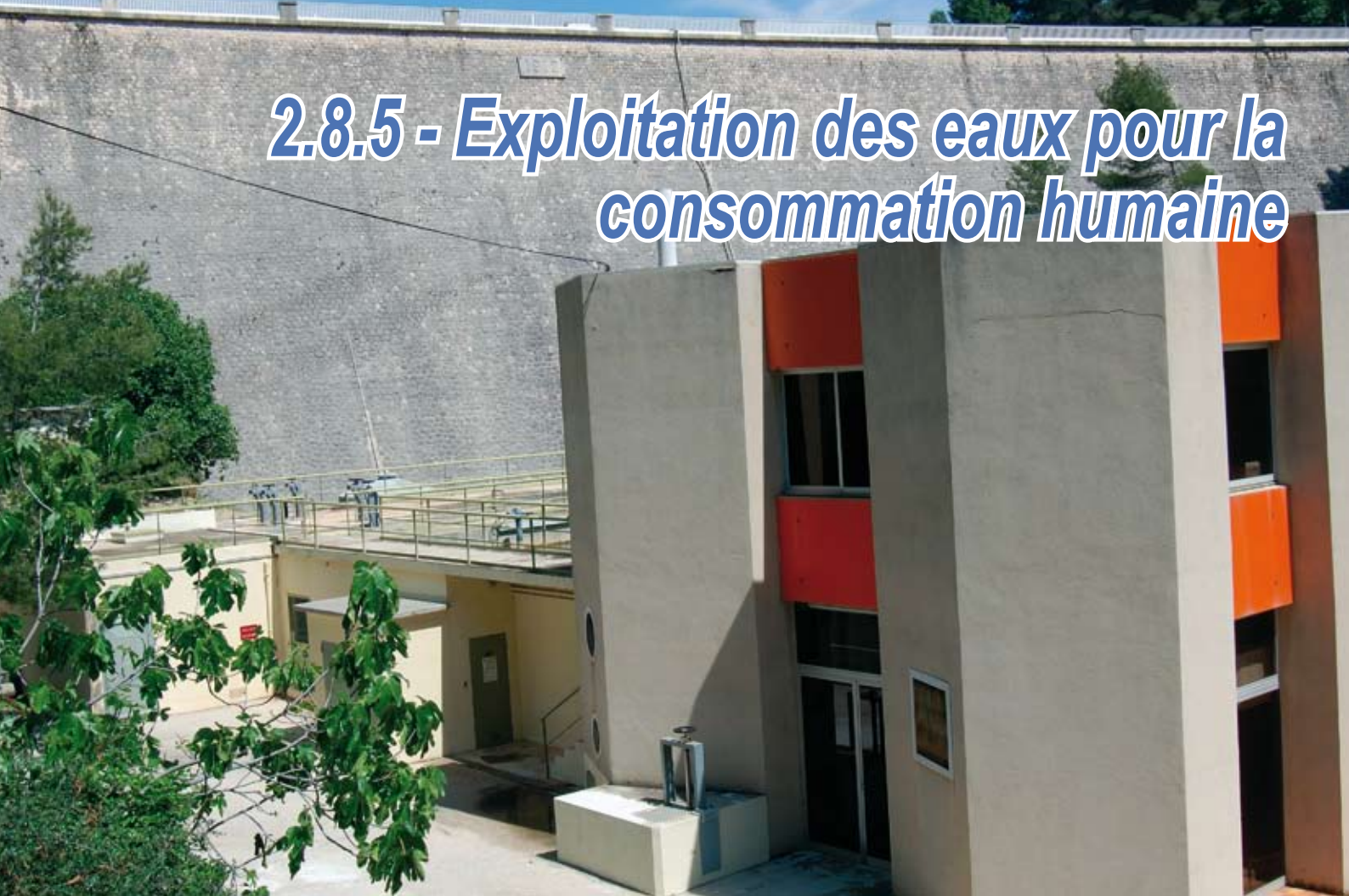
L'usine de traitement des eaux de Dardennes située au pied de la Retenue
