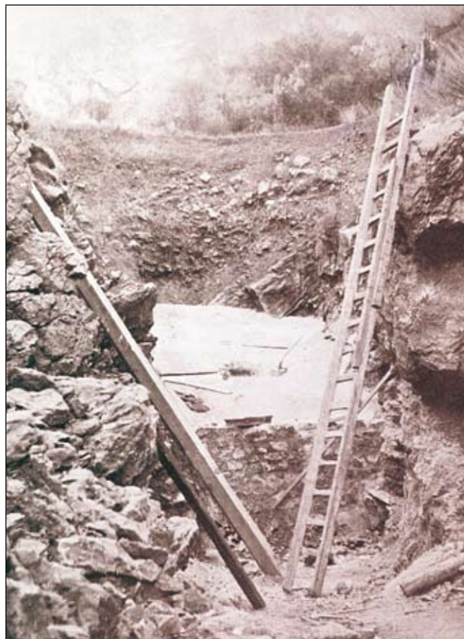
Obstruction de l'entrée de la source du Figuier.
