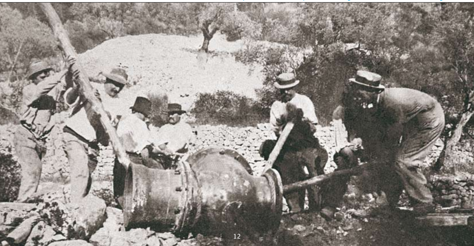
1908 : Pose d'une vanne dans le but de tamponner la source des platanes et d'augmenter le débit du tunnel du Ragas.
