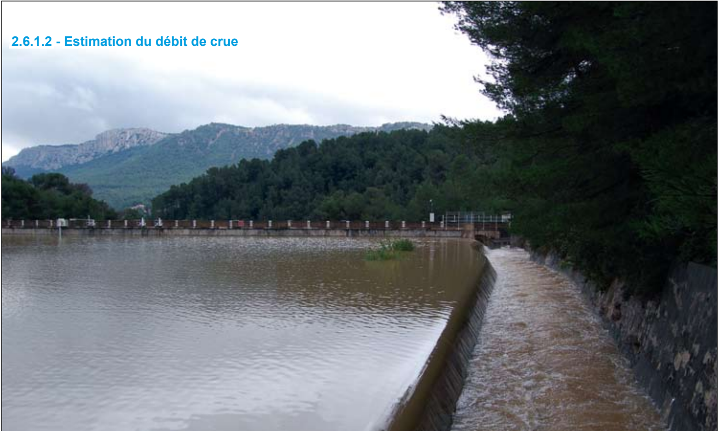
Le déversoir pendant une crue à l'automne 2008.
