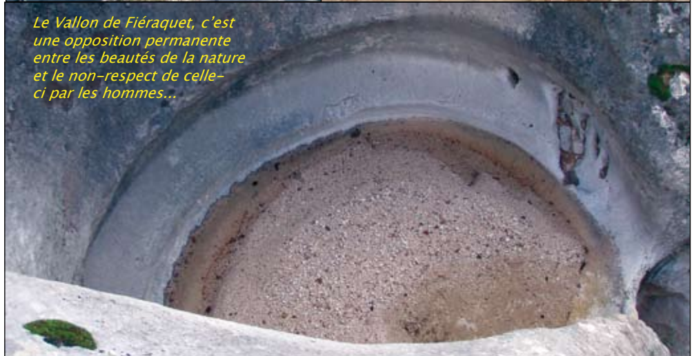
Début octobre 2008, les précipitations importantes se sont abattues sur la région todonnoise. Les eaux souillées par les fines de la carrière rejoignent le Vallon de Fiéraquet en emportant le tout-venant du revêtement de la piste.
