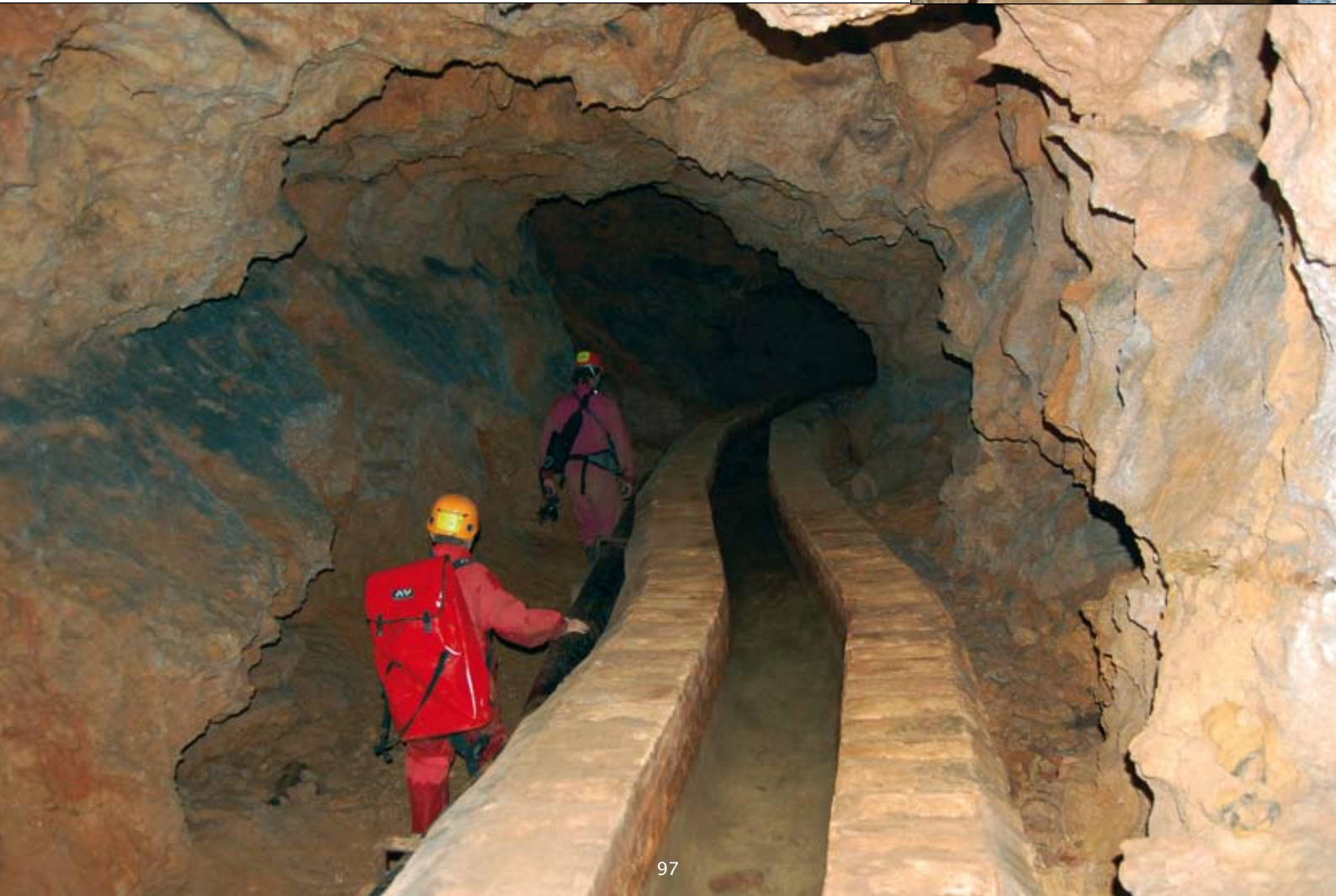
La galerie d'accès à la rivière. Au premier plan le canal et la conduite pour le captage des eaux.
