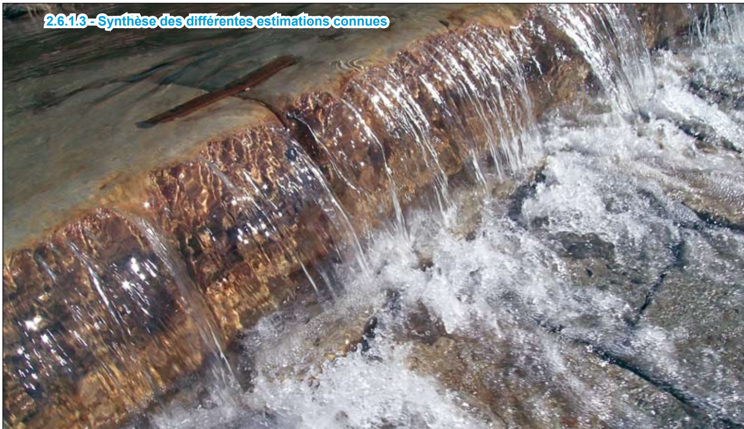
Le seuil de la prise d'eau du Béal située au cœur de la Retenue de Dardennes.
