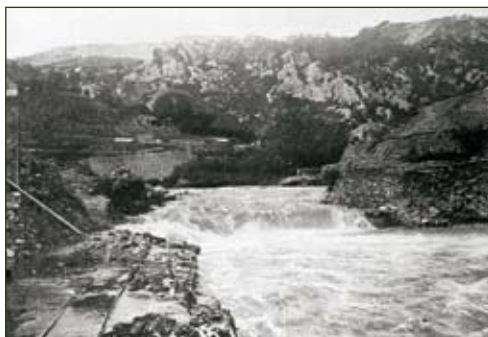
En 1909, le chantier de la construction du barrage a été détruit par une crue.
