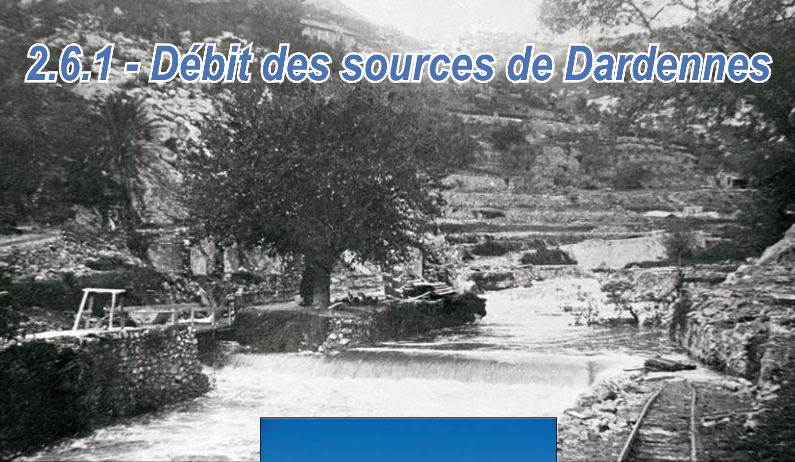
Une crue a détruit le chantier de la construction du barrage qui en est aux prémices...
