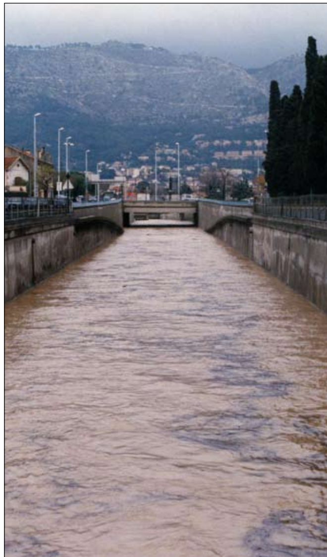
Toujours en janvier 1999, mais au niveau de Pont Neuf. Il est intéressant d'observer les rampes en béton situées sous le pont, de part et d'autre. Elles avaient été installées en vue de faire passer la route sous le Pont Neuf. Ce jour là, elles sont nettement sous l'eau...
