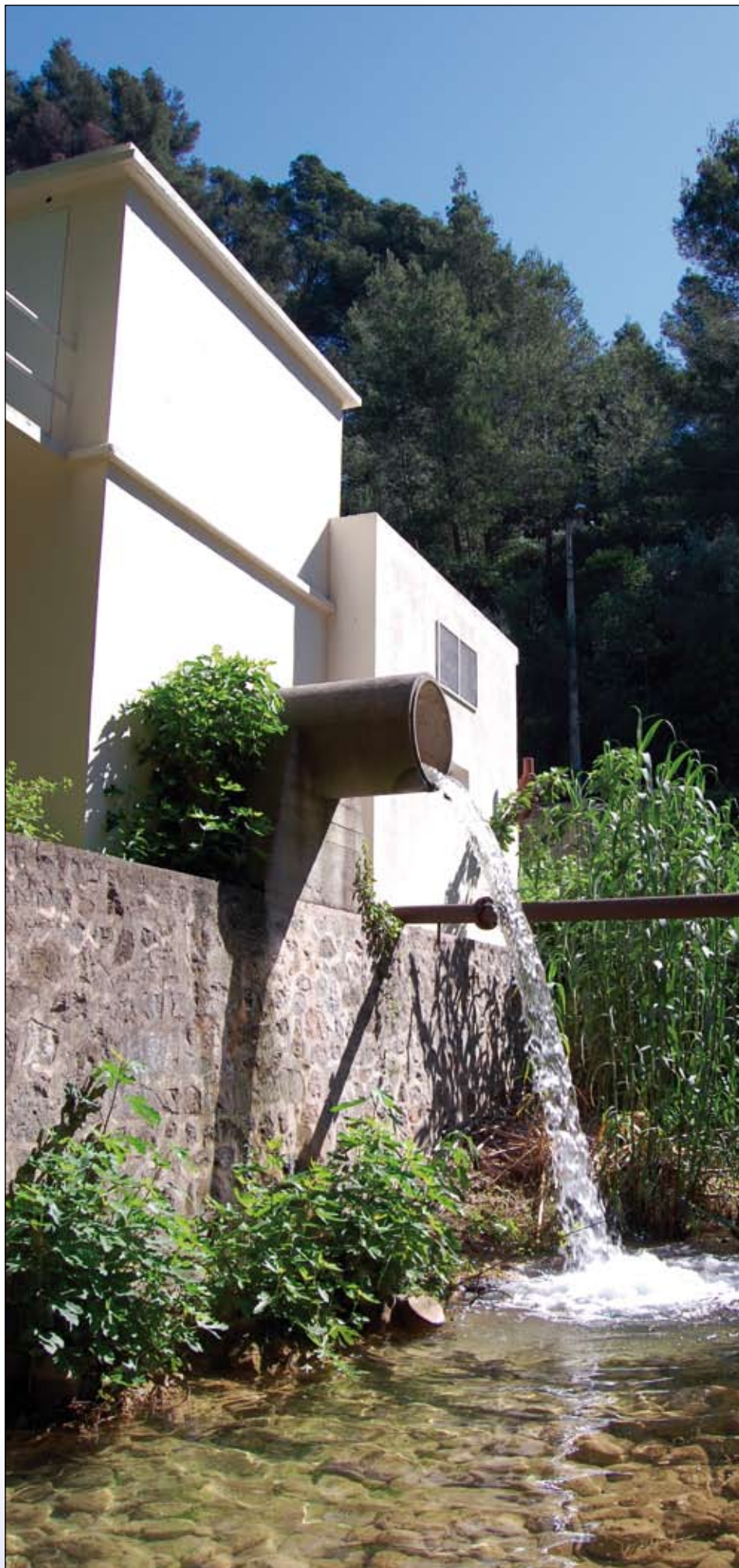
Exhaure située en aval du captage du tunnel du Ragas.
