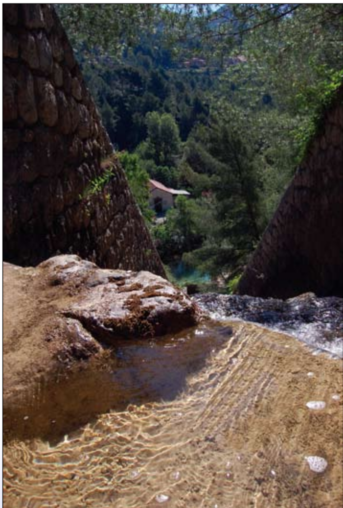
Le déversoir de la Retenue de Dardennes qui rend ses eaux au Las ...
