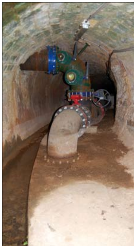
Le Tunnel du Ragas.
