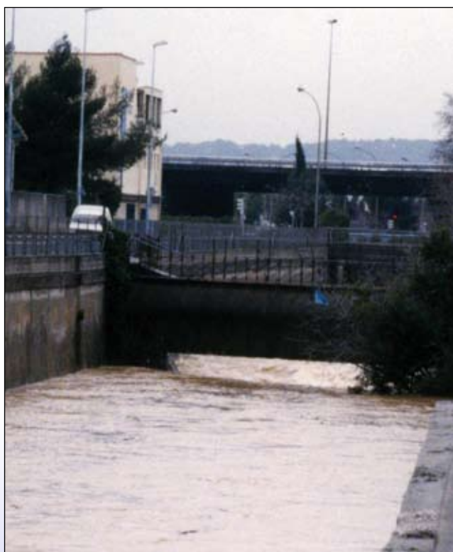
Sur cette photo de 1999, on constate que le rétrécissement de la passerelle fait monter le niveau sur toute la partie amont de la Rivière Neuve.
