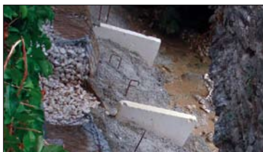
Le système de filtration mis en œuvre au pied de la retenue a-t-il été efficace ?
