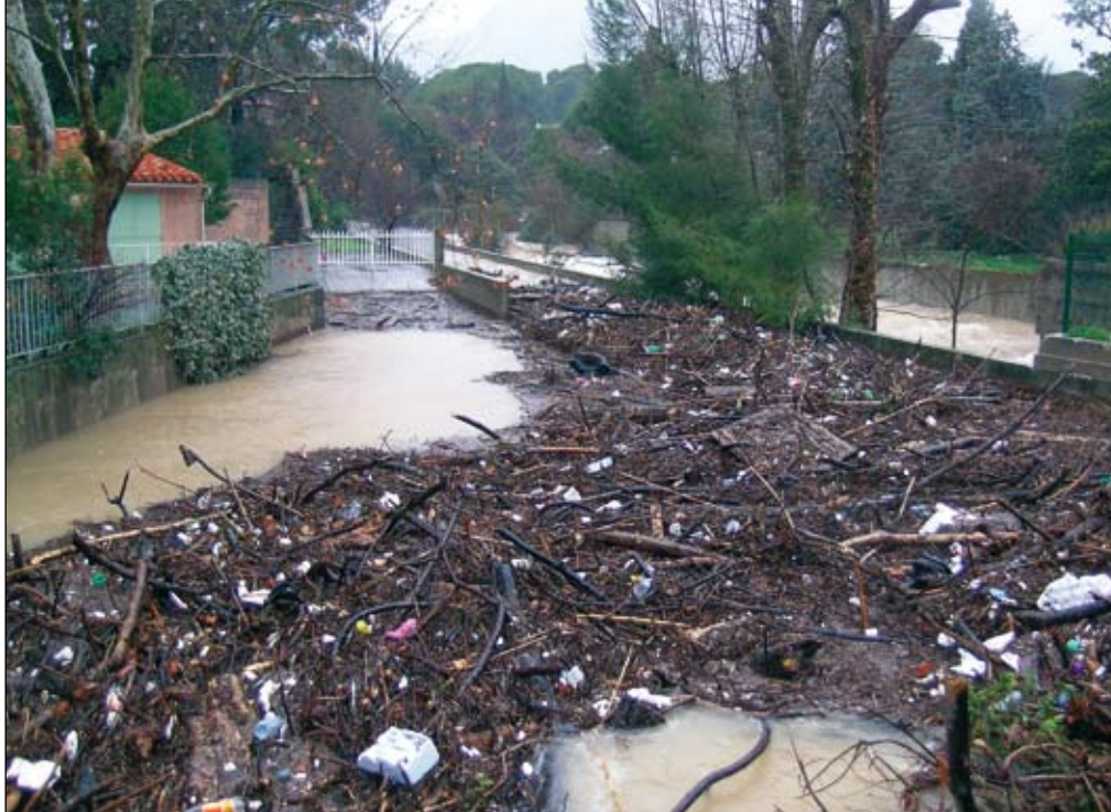
La crue de Janvier 2006 a charrié des tonnes de bois qui viennent s'accumuler devant la grille d'accès à la Rivière Couverte. Contrairement à ce qu'on pourrait penser en regardant cette photographie la ville de Toulon entretient très régulièrement le site en purgeant les immondices. Le problème vient de l'amont où certains secteurs, souvent privés, sont laissés à l'abandon et la force publique ne peut pas légalement intervenir sans la mise en oeuvre de dispositifs législatifs lourds...
