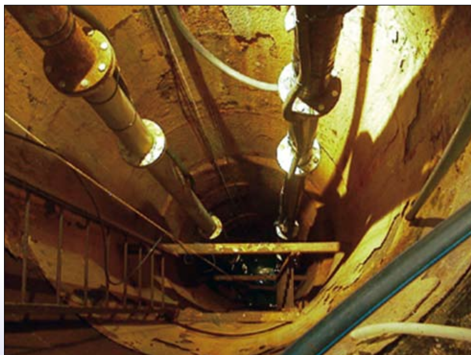
Exemple de puits de captage en nappe.
