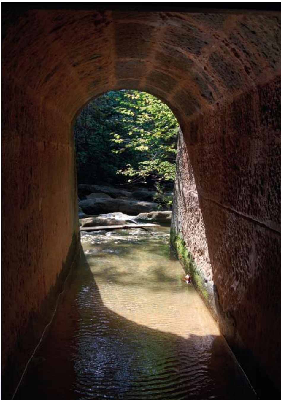
Un des tunnels de la Retenue des Trois Martelières.
