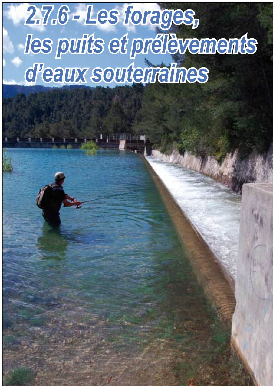
Le déversoir de la Retenue de Dardennes en crue. Les eaux souterraines sont captées dans le barrage depuis 1912.
