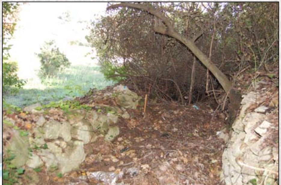
Le canal d'irrigation situé en aval de la source.
